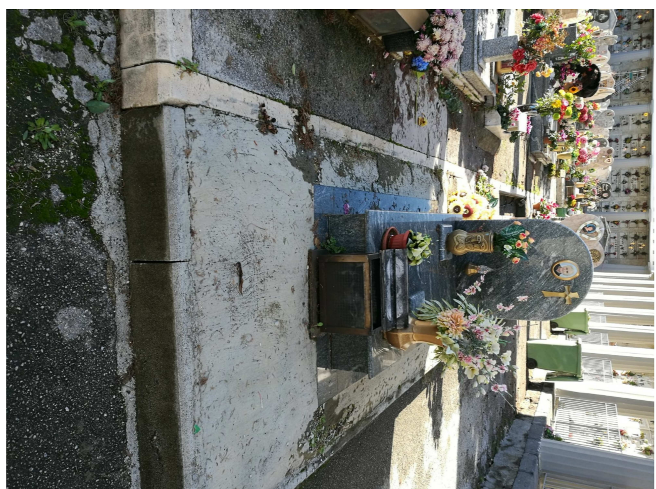
particolare campi di illuminazione da rinnovare nell'ambito 1
